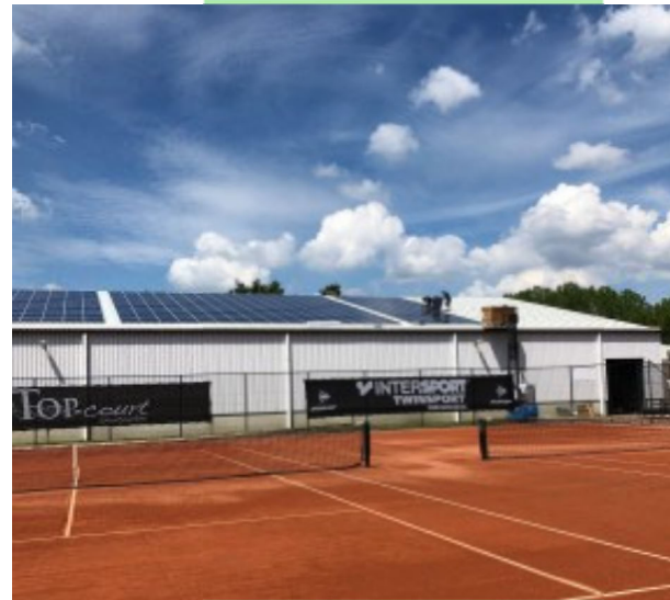
foto van IJTC zonnepanelen op dak Tennisvereniging IJTC Groenvliet
