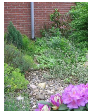
Foto: HDSR, afgekoppelde regenpijp
