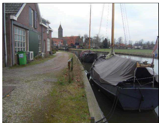
Jaagpad begin 2017 voor de renovatie
