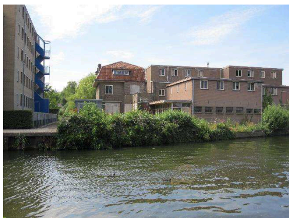
Bedrijfsbebouwing voormalige graanhandel aan de Rijnzijde
