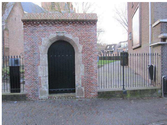
Realisatie plaatsing Gildepoortje
