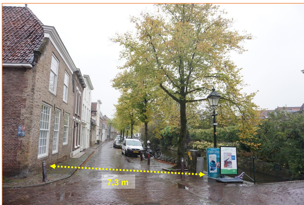
Foto 6: Beeld van het straatprofiel, van rooilijn woning tot aan rand kademuur.
