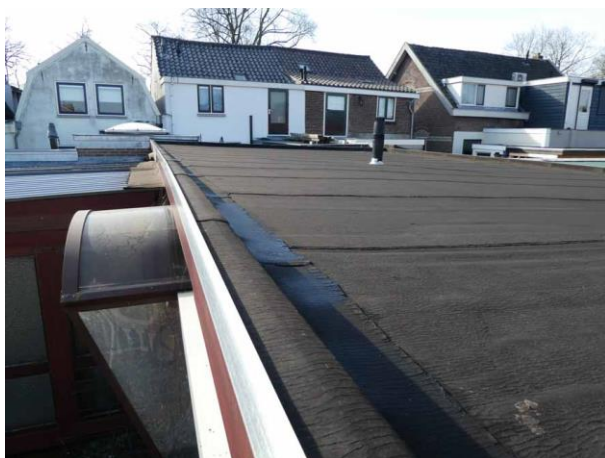
Figuur 12: Het dak van de woning
