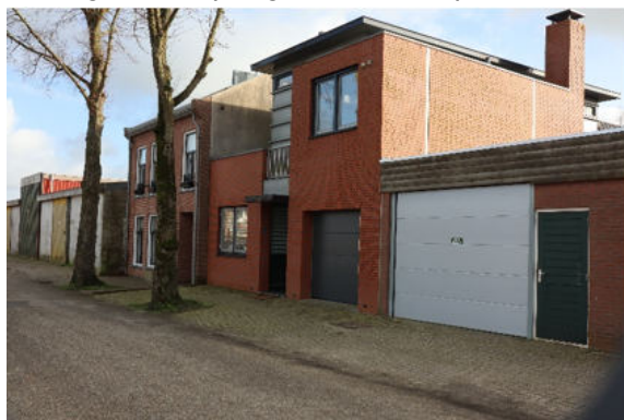
Woningen met opslag aan Plesmanplantsoen.
