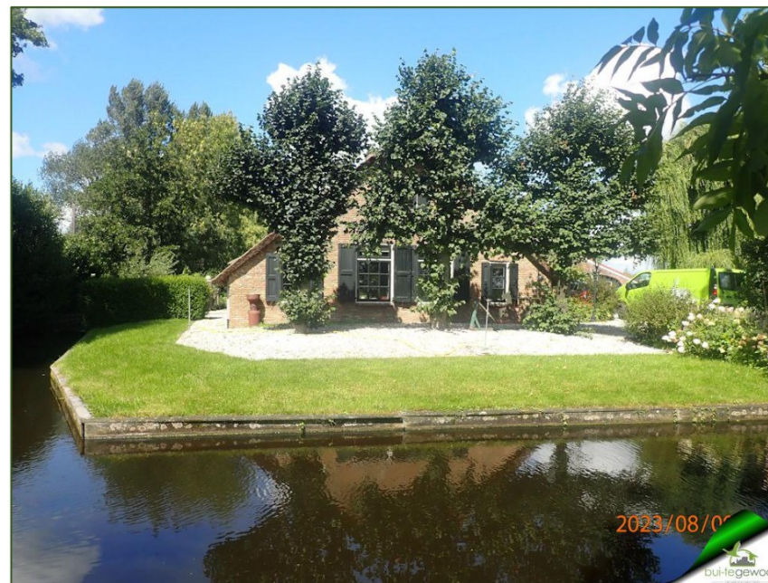
Figuur 2. Ruige weide 23 Oudewater vanaf de voorzijde (wegzijde)
