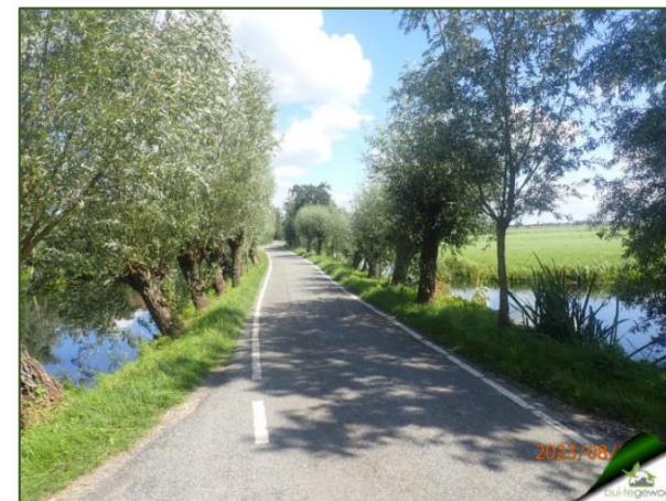
Figuur 6. Impressie polder weg Ruige Weide ter hoogte van de projectlocatie
