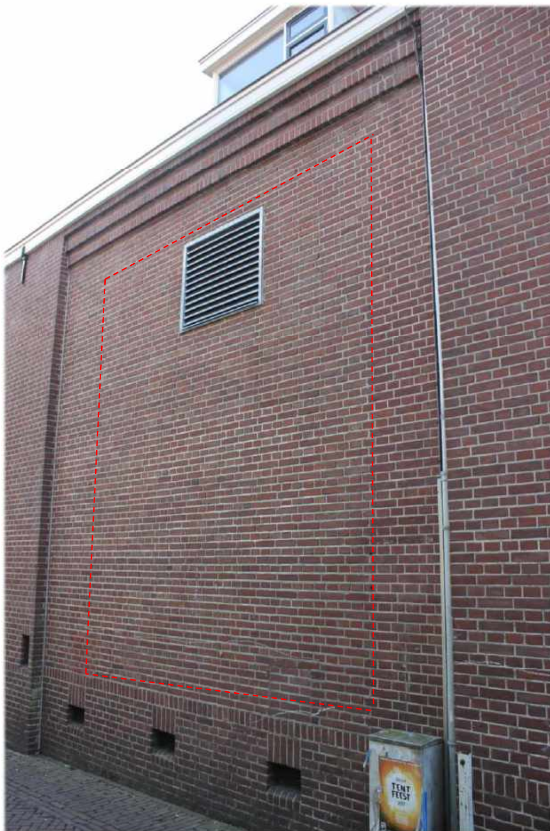
De dichtgemetselde opening in de eerste travee.
