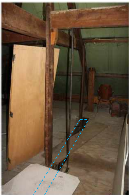
De zolder boven het podium. Met stippellijnen is de sleuf voor het filmdoek aangegeven. De verticale balken zorgden voor de geleiding.
