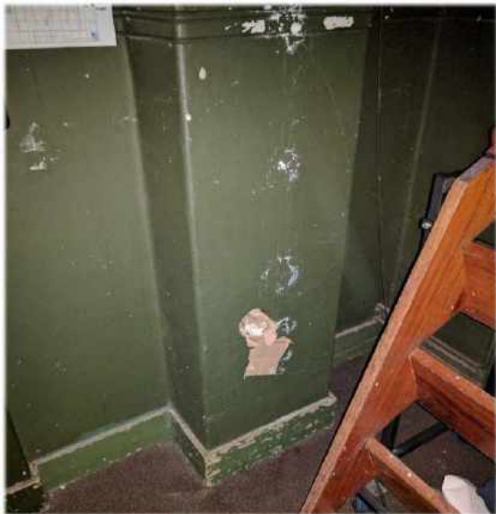
De aansluiting voor de kachel op het podium. Bemerkt de gestucte bovenrand van de lambrisering.
