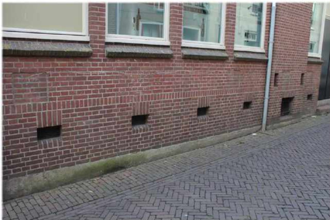
Detail van de 3 e travee
