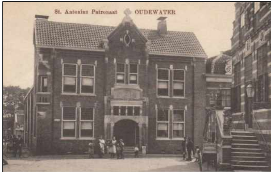
Figuur 2.7 Zicht vanaf de Visbrug in noordoostelijke richting in het begin van de 20 e eeuw 1900 met centraal op de ansicht het patronaatsgebouw en rechts daarvan het andere pand dat binnen het plangebied valt (In Oude Ansichten 2017).
