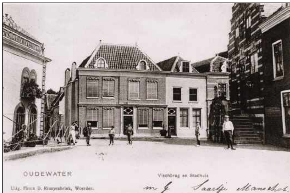
Figuur 2.6 Zicht vanaf de Visbrug in noordoostelijke richting omstreeks 1900 met centraal op de ansicht de oude bebouwing (vermoedelijk alle drie de panden) in het plangebied (RHC Rijnstreek 2017, fotonr. 00300).
