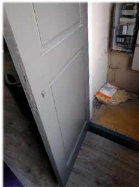
De kast met originele paneeldeur en vloer.
