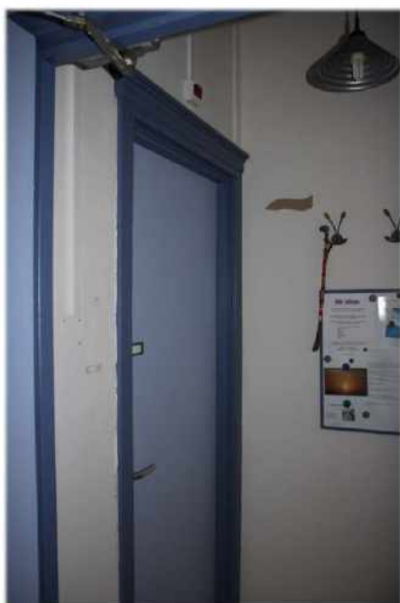
Origineel deurkozijn met kroonlijst op de verdieping Van het voorste bouwdeel.
