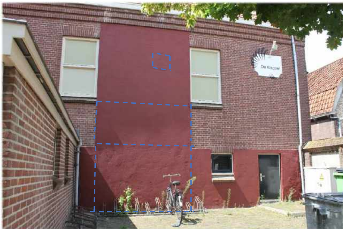
De gevonden bouwsporen in het pleisterwerk. Op advies van de architect is het pleisterwerk in 1978 baksteenkleurig geschilderd.
