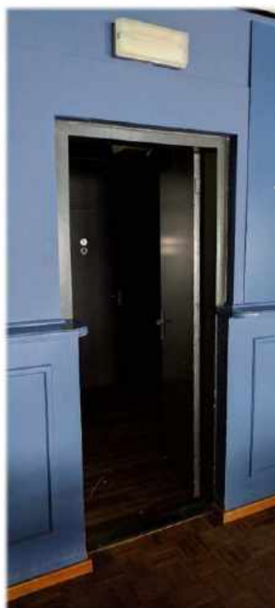
Origineel kozijn vanuit de zaal naar Het voormalig herentoilet.
