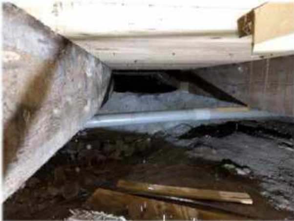
Een kijkje onder de vloer in de zaal. Alleen de balken zijn nog origineel.
