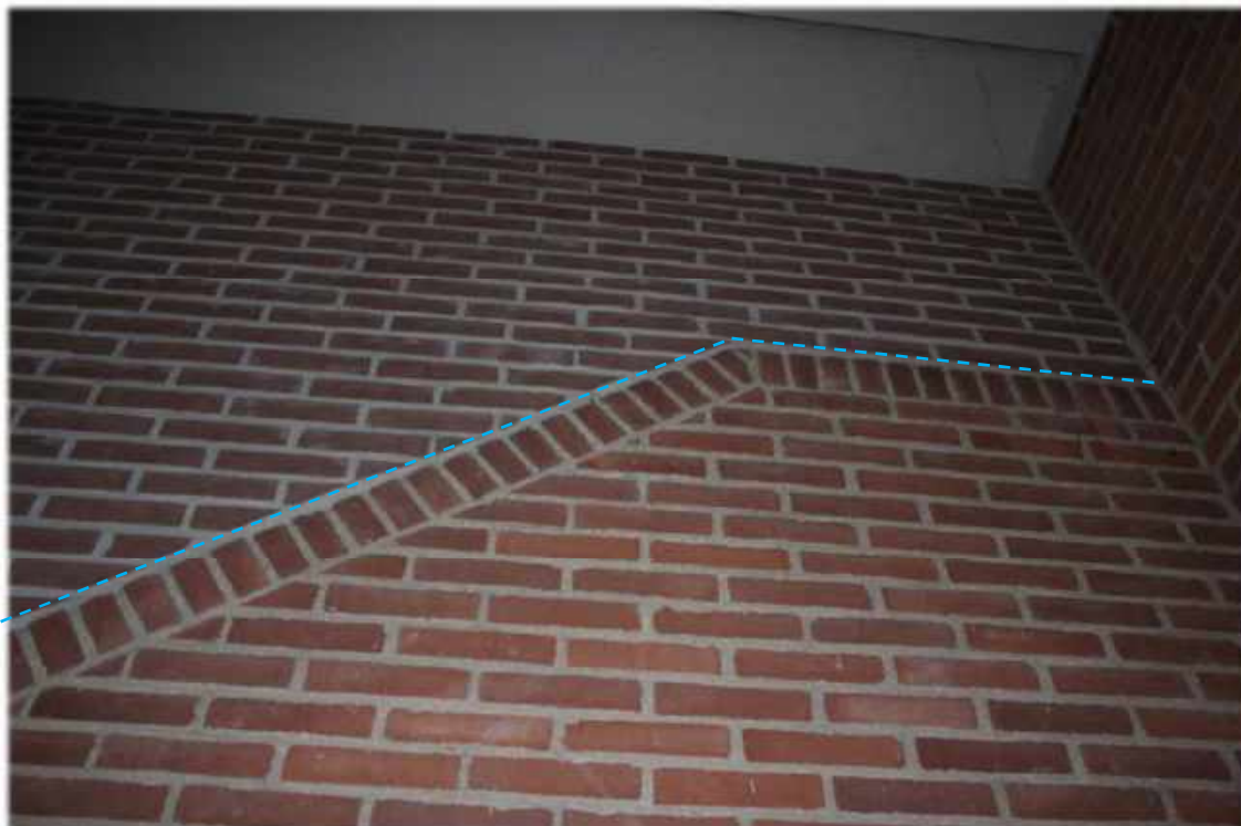
Het gemetselde muurtje als trapeuning en bordes, dat later naar boven toe is dichtgemetseld.
