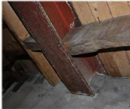
De ijzeren balk in de kelder. De kinderbalken zijn met aparte klossen opgelegd.
