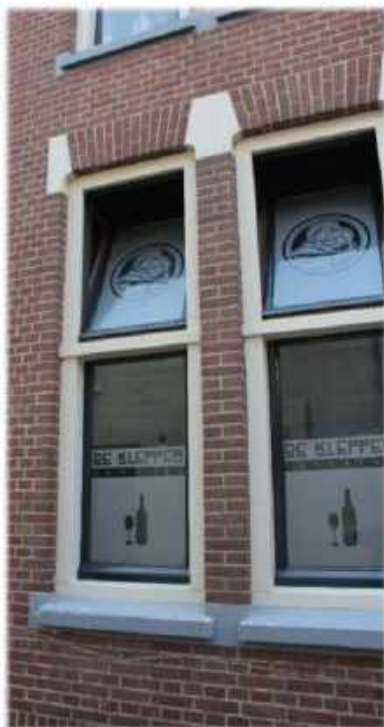
Het in zuiver staand verband uitgevoerd metselwerk
