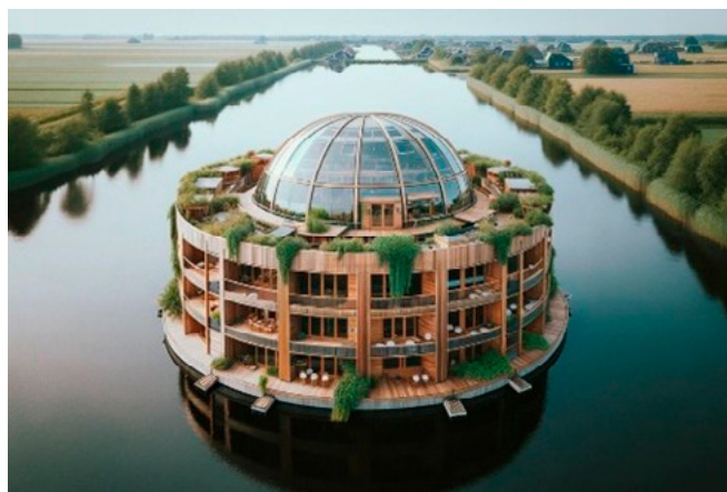
Drijvende appartementen (Bron: Breman.nl)
