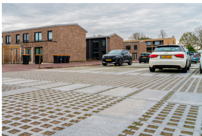
Parkeren op waterdoorlatende parkeerterreinen (Beeld: Haarsma Infra)
