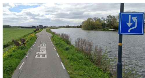
Figuur 3-5: Bebording en een duidelijke verbreding van de weg vergroten de zichtbaarheid van passeerhavens
