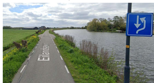
Figuur 4-2: Bebording en een duidelijke verbreding van de weg vergroten de zichtbaarheid van passeerhavens
