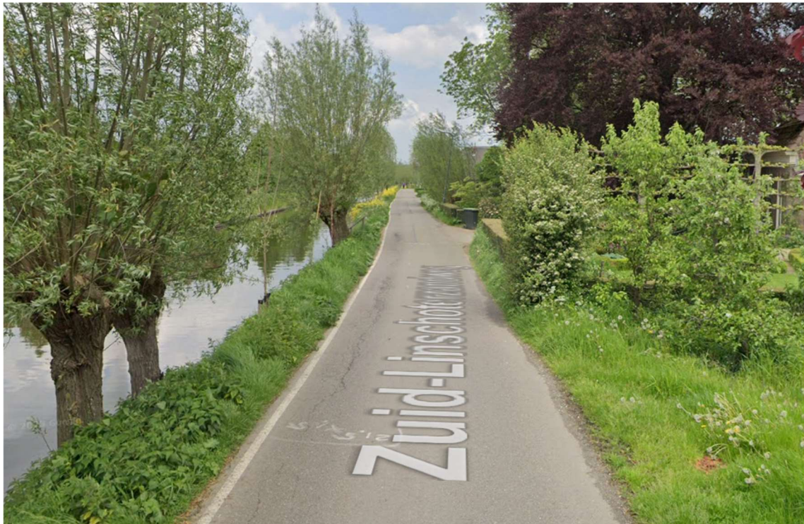
Afbeelding 5. Wegvak Zuid-Linschoterzandweg (bron: Google Streetview 2023).
