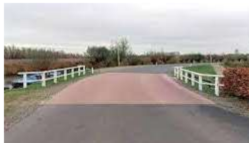
Figuur 7-4: Door aanpassingen op de rijbaan of objecten in de omgeving, zoals deze witte hekjes, is het mogelijk om weggebruikers meer bewust van hun omgeving te laten rijden
