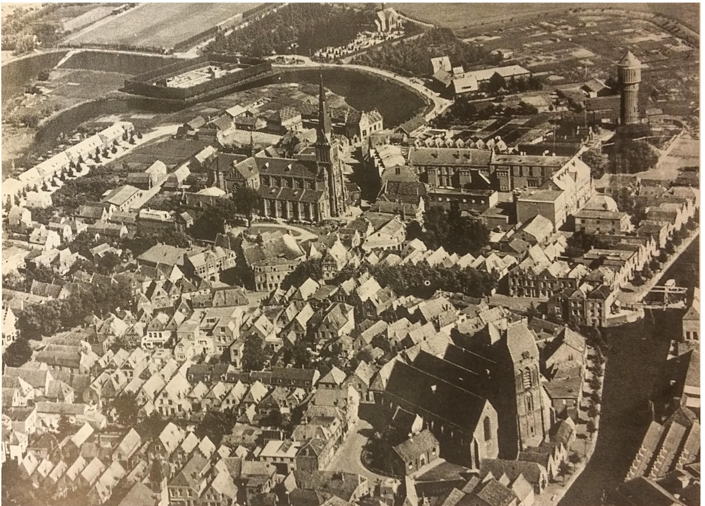
Afbeelding uit het archief van de gemeente Oudewater luchtfoto uit 1948 met linksboven achter de Sint Franciscuskerk het Bolwerck.
