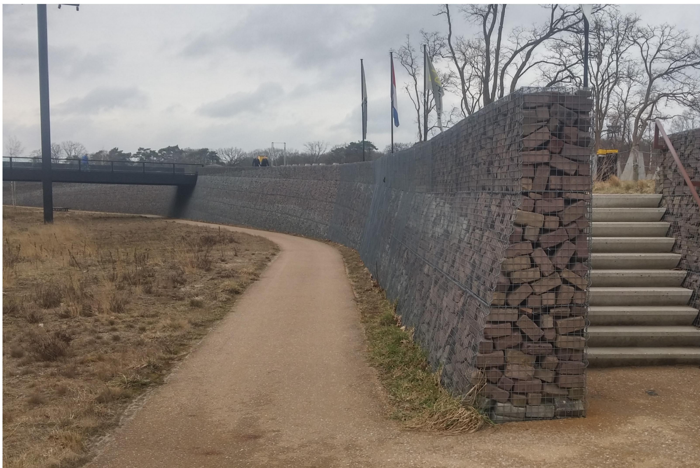
Referentiebeeld wal van schanskorven als alternatief op metselwerk militair museum Soesterberg.
