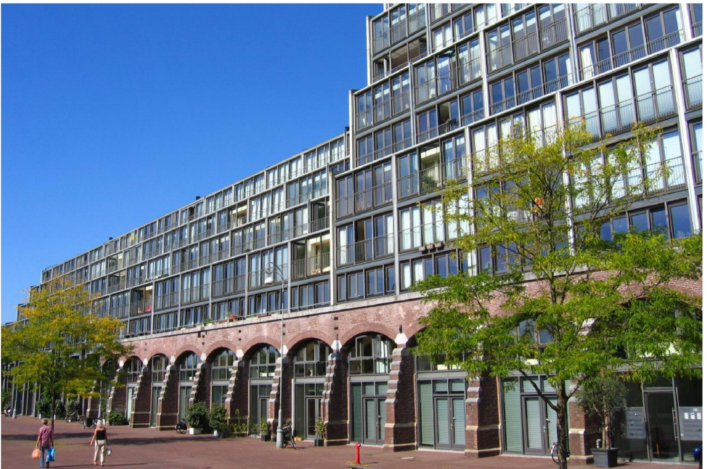
Referentieproject Aquartis in Amsterdam, moderne architectuur op een gemetseld basement.
