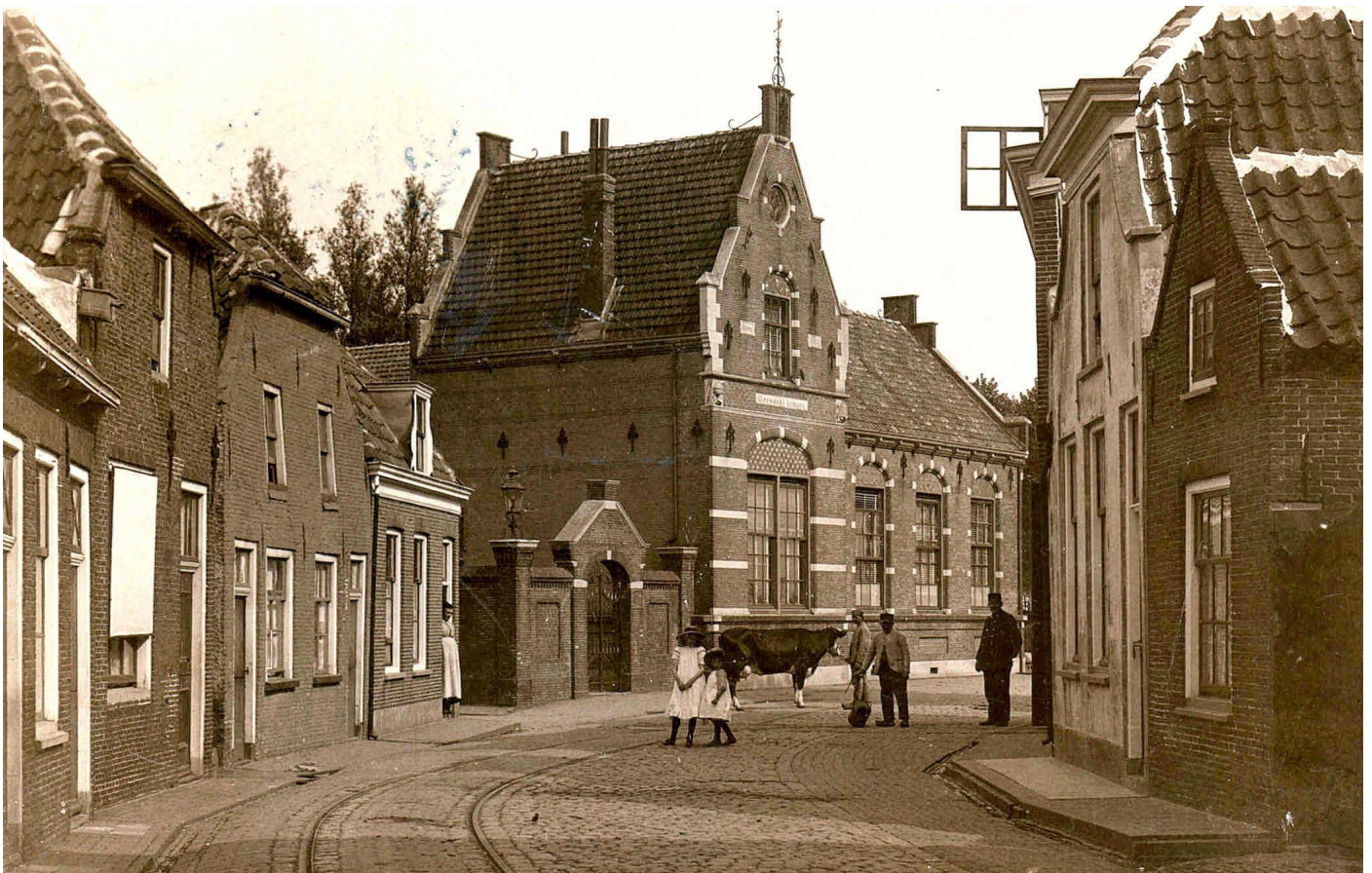
Afbeelding uit het archief van de gemeente Oudewater van school en steeg, de St Janstraat was op dat moment niet breder dan een paar meter terwijl het nu een tweebeaans doorgaande weg is.
