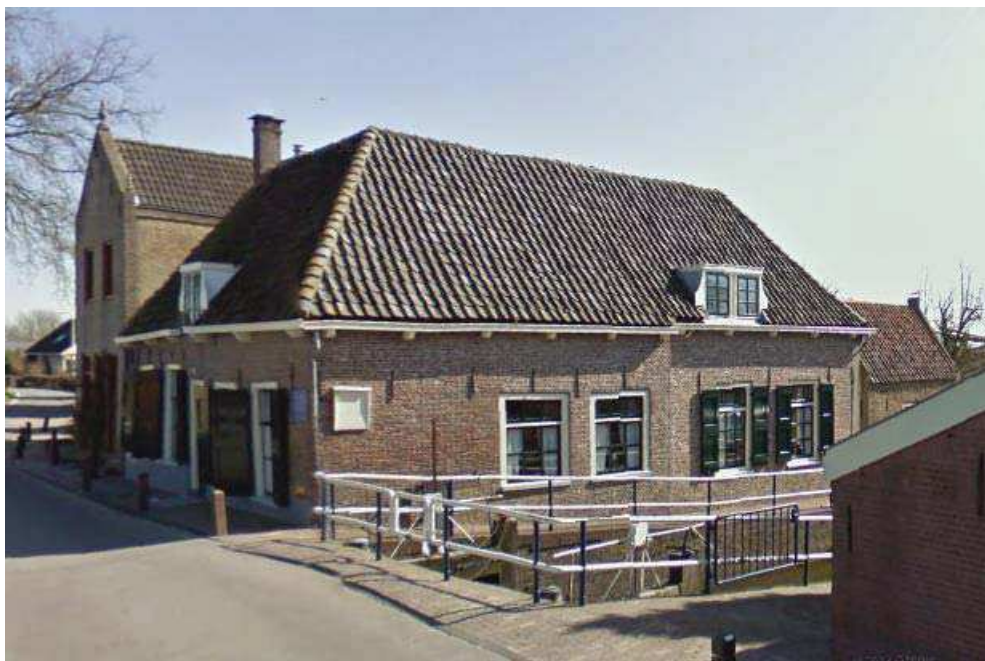
Figuur 4.3 Sluiswachtershuis en schutsluis (bron: google maps)
