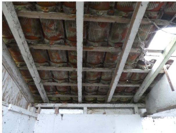
Figuur 12 Dak van binnenuit
