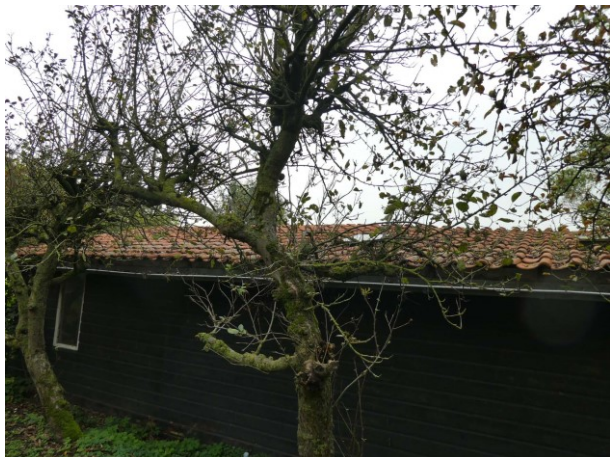
Figuur 11 Dakpannen van buitenaf
