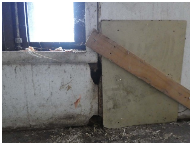
Figuur 16 Muren afgewerkt met platen
