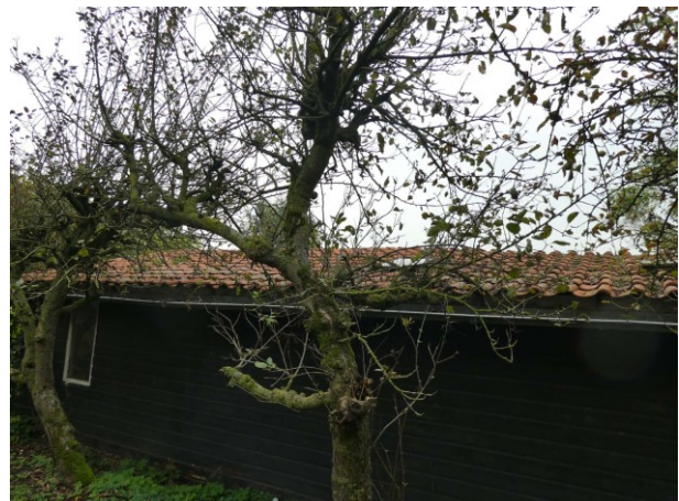
Figuur 4 Dak van de schuur met dakpannen
