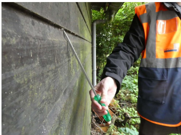
Figuur 15 Planken zonder ruimte voor schroevendraaier
