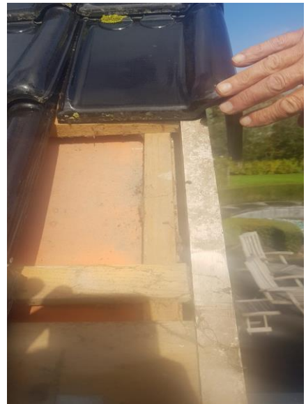
Figuur 10: Linksboven schuur (2), rechts en onder de constructie onder de dakpannen van schuur (2)
