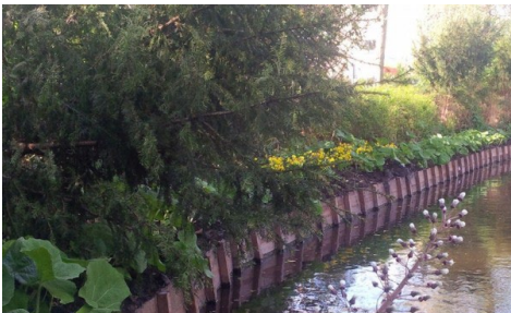
Lichte constructieve beschoeiingen van hout
