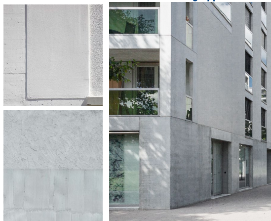
Lichte gevel voor appartementen (stuc- of metselwerk) met robuuste plint (natuursteen of beton)
