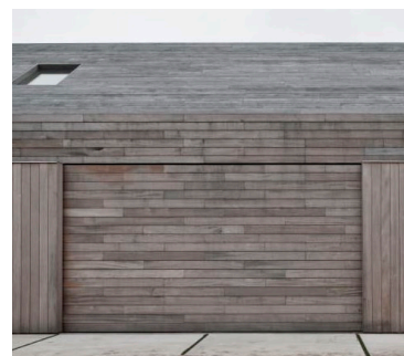
Horizontale en verticale lattenstructuur voor gevelopeningen (mogelijke garage-entree, trafodeur en bergingsdeuren)
