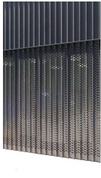
Geïntegreerd en gedecoreerd hekwerk rond fabrieksterrein uit veiligheid en om geluid te dempen
