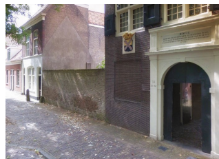
Historisch hofje: entree en muur
