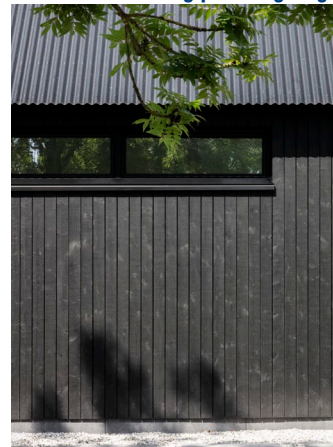
Antracieten verticale houten gevel Grijze vezelcementen dakbedekking
