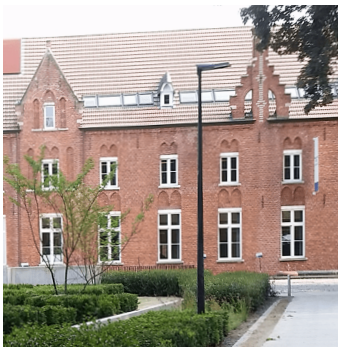
Dakkapellen liggen in het vlak van de gevel
