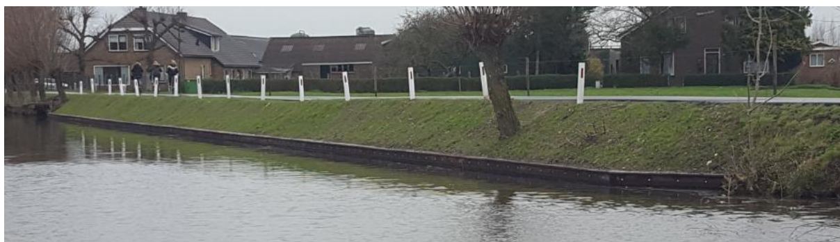
Figuur 2.2. Geplaatste noodbeschoeiing langs de Lange Linschoten uit 2018.
