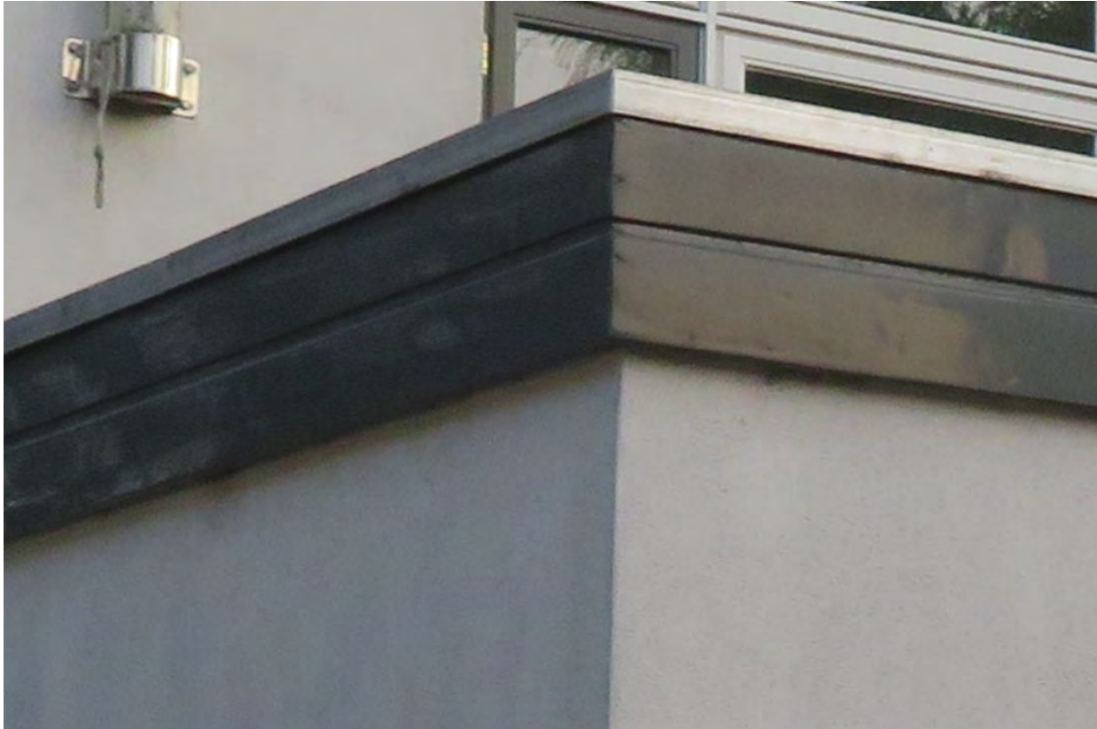
Geen ruimte voor vleermuizen onder de boeidelen aan de voorzijde van het pand. De achterzijde van het opstal en de schuur hebben geen boeidelen.
