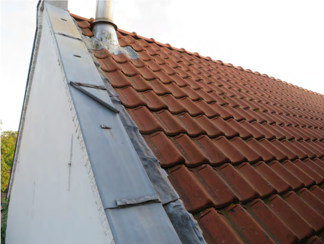
Daklijst en loodslabben sluiten goed aan
