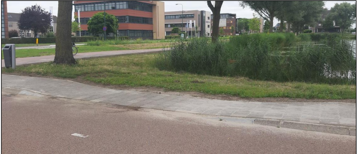
Figuur 2 Verlaging trottoir ter voorkoming van wateroverlast
