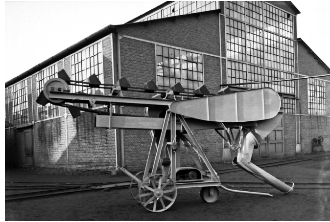
Machine fabriek elementen
