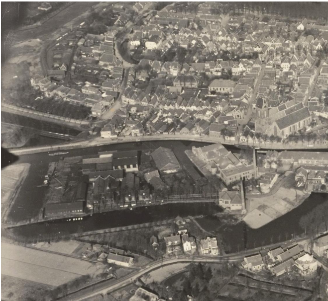
In 1945, een nog grotendeels intact zijnde waterstructuur
